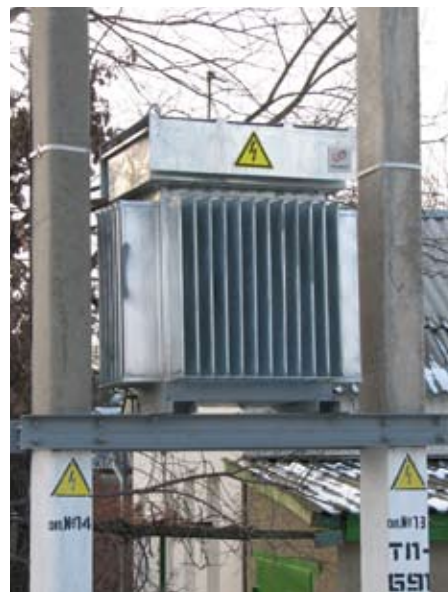
Вольтодобавочный трансформатор
